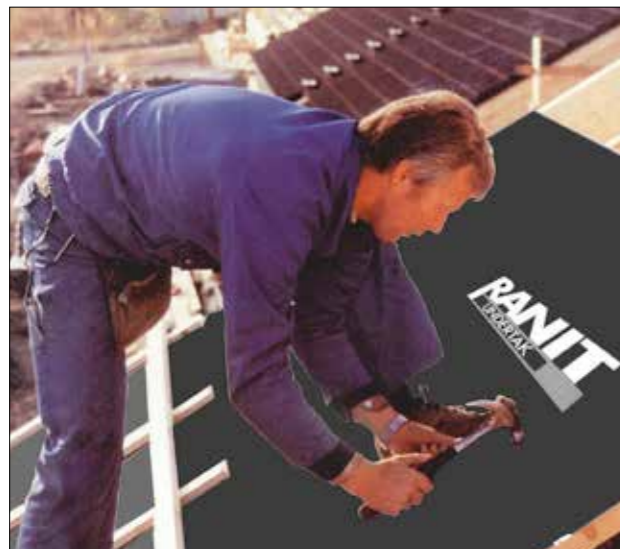
Montering av forenklet dampåpent undertak. Kilde; Sintef Byggforsk.
