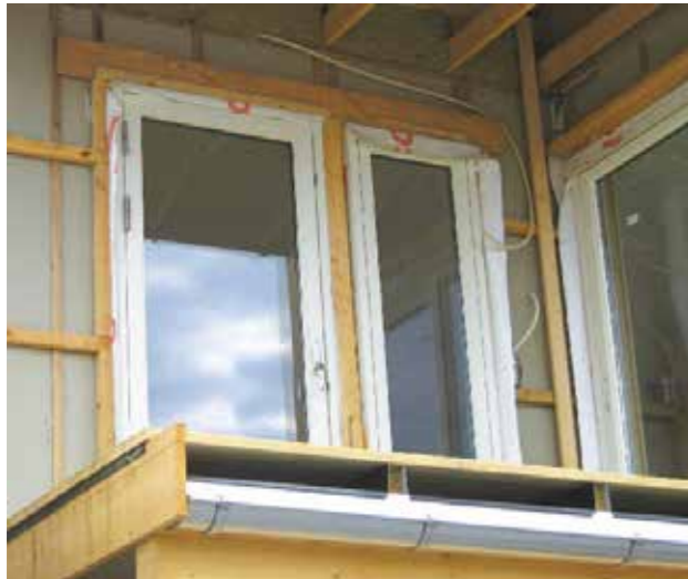
Tetting med vindsperre rims.
