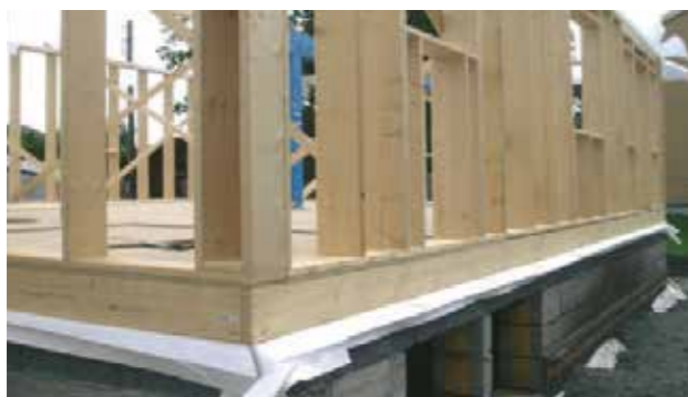
Svillemembran med vindsperreflik.
