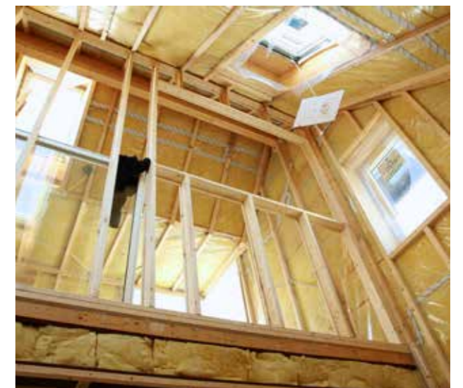
Innvendig påføring muliggjør inntrukket dampspærre.
