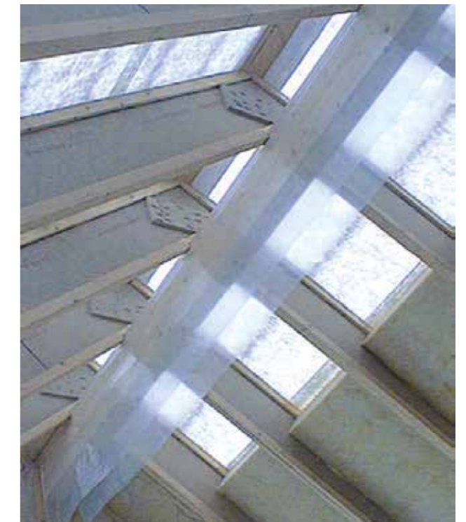
Dampsperre trukket over mønsås.
