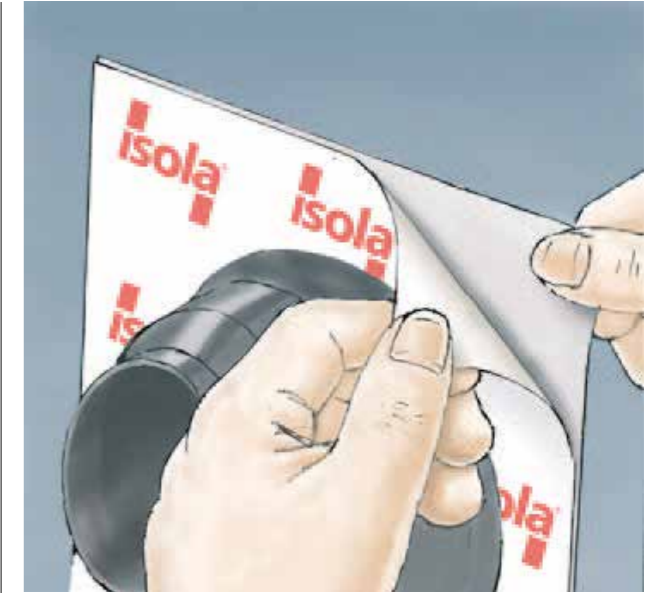
Rørmansjett med klebekrage.
