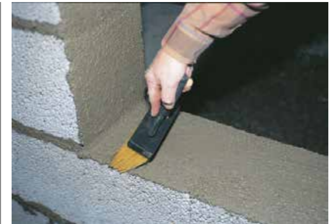
Bruk av pussmørtel for å lufttette lettklinkerblokker i vindus-smyg før innsetting av vindu.
