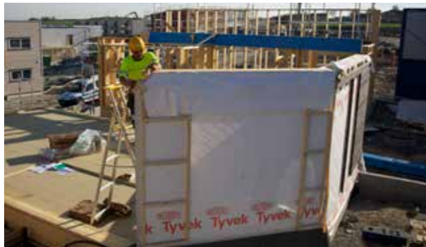
Fuktbeskyttelse og dobbel vindtetting.
