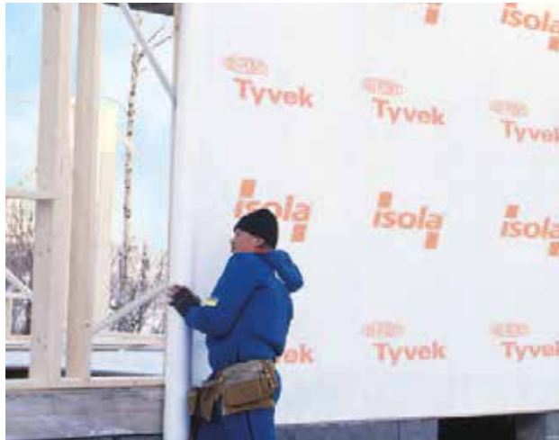
Montering av etasjehøy vindsperre.
