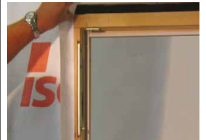
Tetting av vindusfuge med vindspærre tape.
