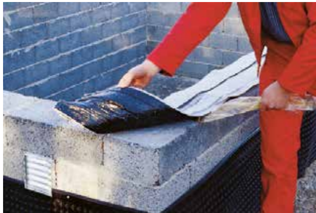
Svillemembran med vindsperreflik.
