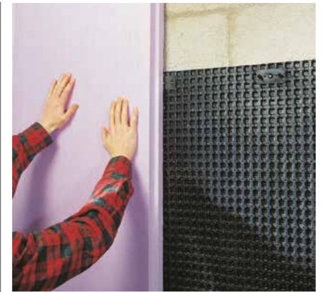
Grunnmursplate med utvendig isolering.
